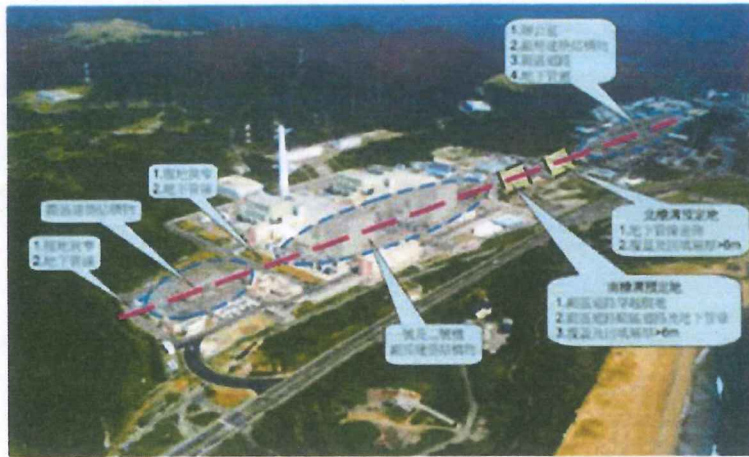
圖 5-3.3 2013 年核四廠區槽溝開挖場址研擬評估示意圖
